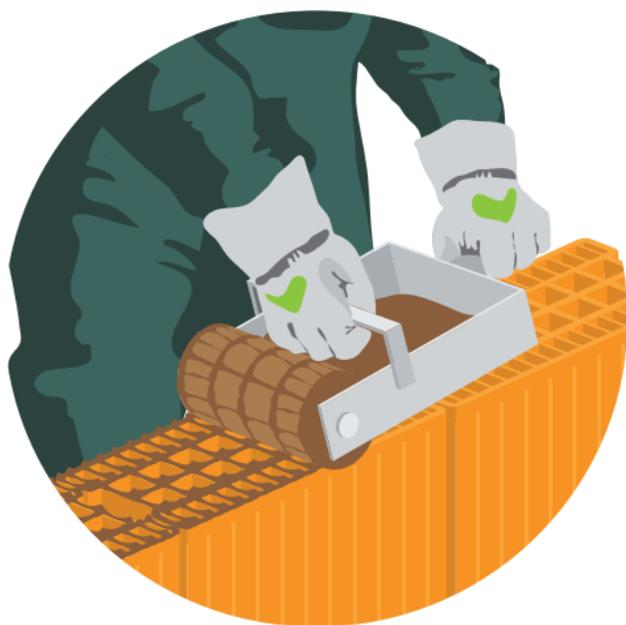
Fig. 2 : Encollage des briques à joint mince
